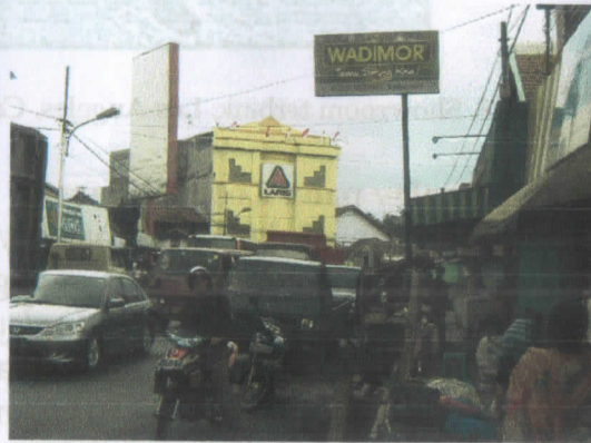
Fasade bangunan yang berbeda dengan sekitarnya
